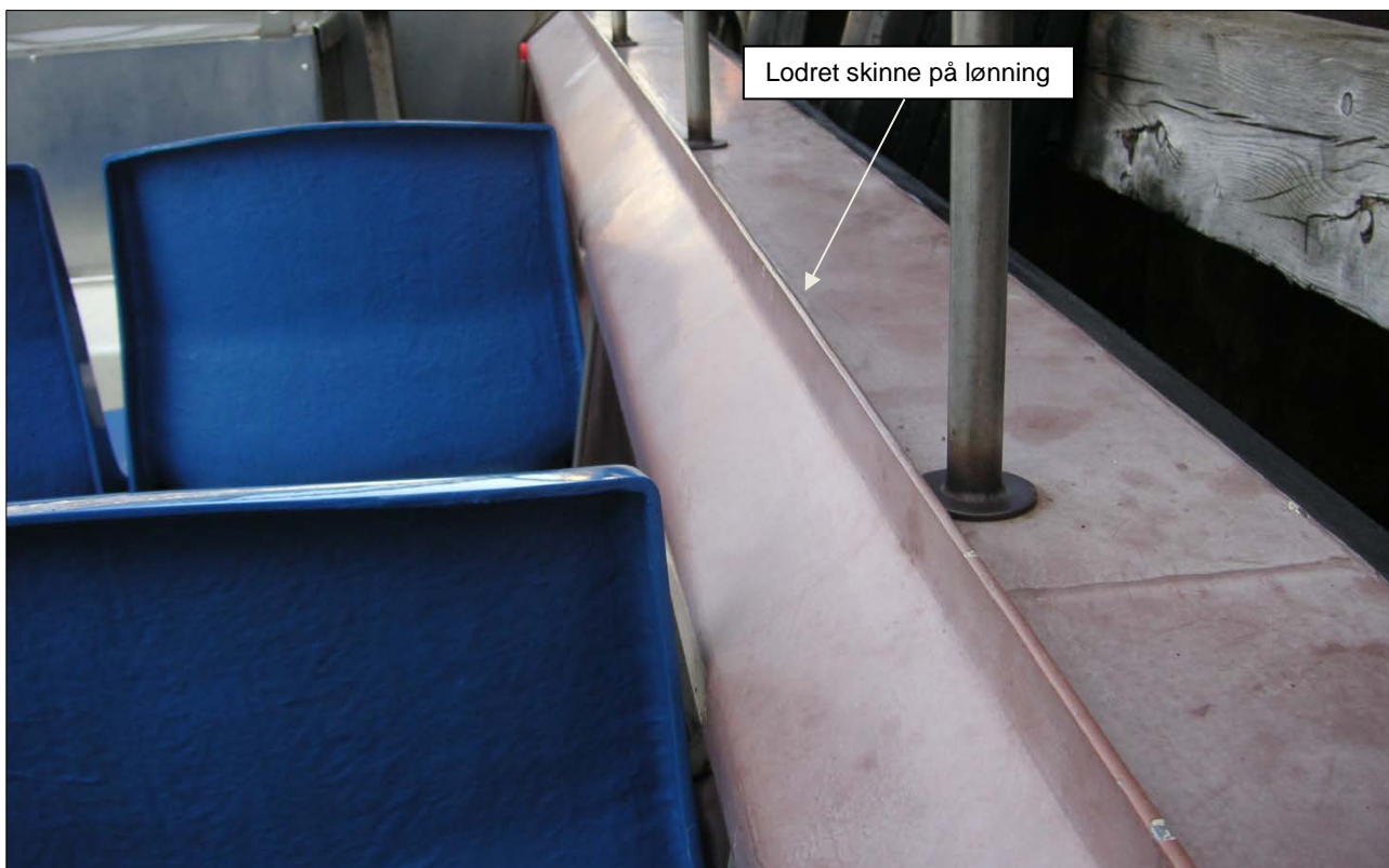
Figur 8: NETTO VII, agterste styrbord passagerafsnit, detailbillede af lønning med lodret skinne Kilde: Den Maritime Havarikommission
